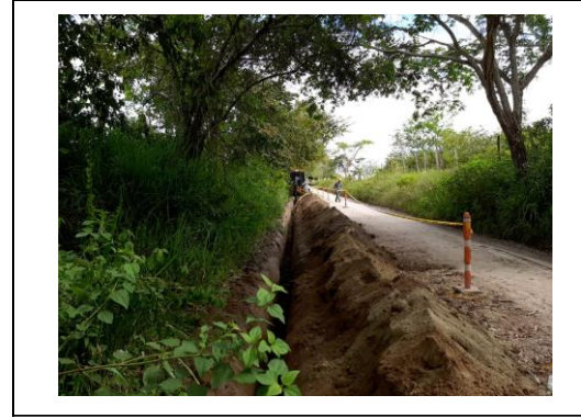
FOTO 2: Excavación Mecánica
